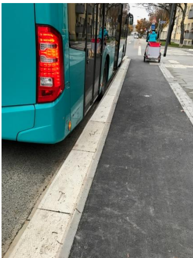
Abb. 4 u. 5: Hochbord mit Spurführung, ermöglicht dichtes Heranfahren (Foto: Müller)
