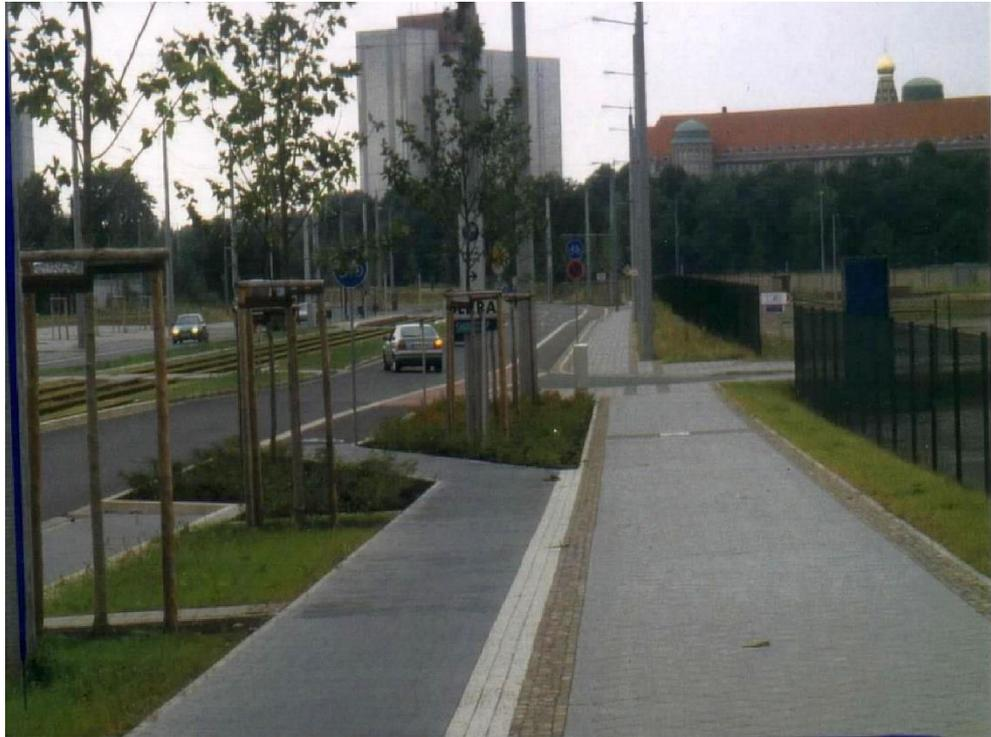
Abbildung 7 Überleitung eines Radweges in einen Radfahrstreifen vor einer Einmündung
