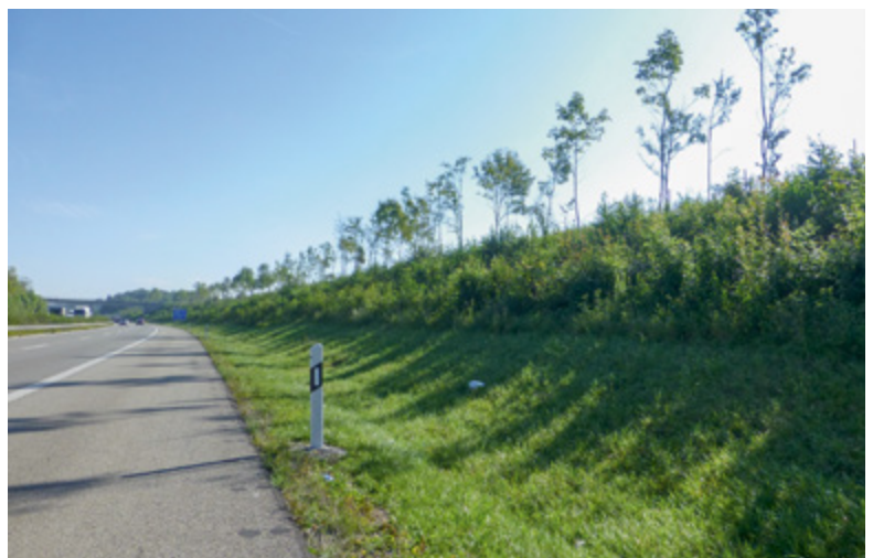
Im Zuge der Pflege stehengelassene Gehölze
